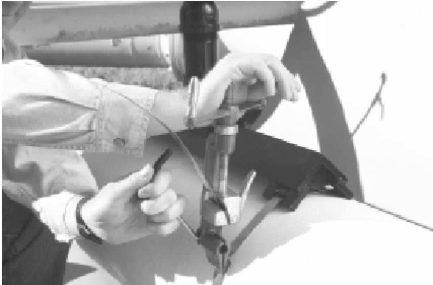
图 4. 剪掉多余的固定带
