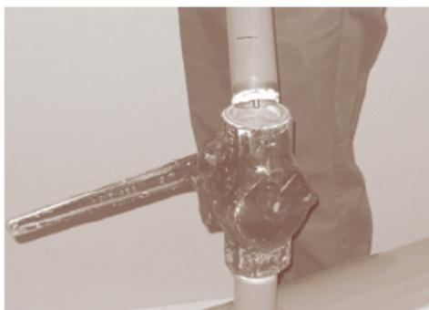
图 13: 安装钻孔机
